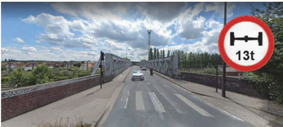
Figure 8 : pont ferroviaire de Longueau
